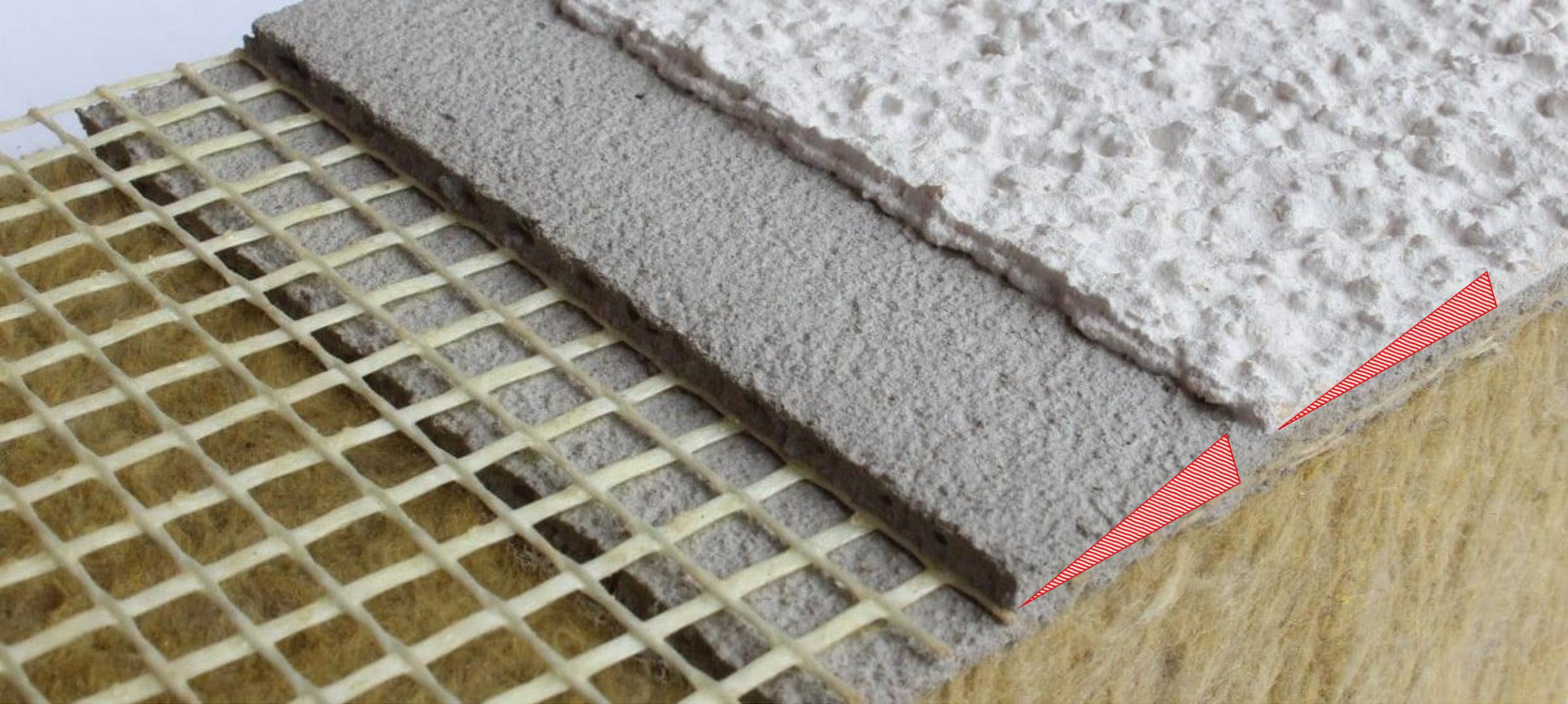
Une fois les composants du système découpé sur le périphérique et espacé de 10 cm, composant par composant, il y a lieu de procéder au ponçage en biais du sous-enduit de mortier collé sur l'armature ainsi que de l'enduit et/ou crépi, conformément au présent exemple repris ci-dessus.
