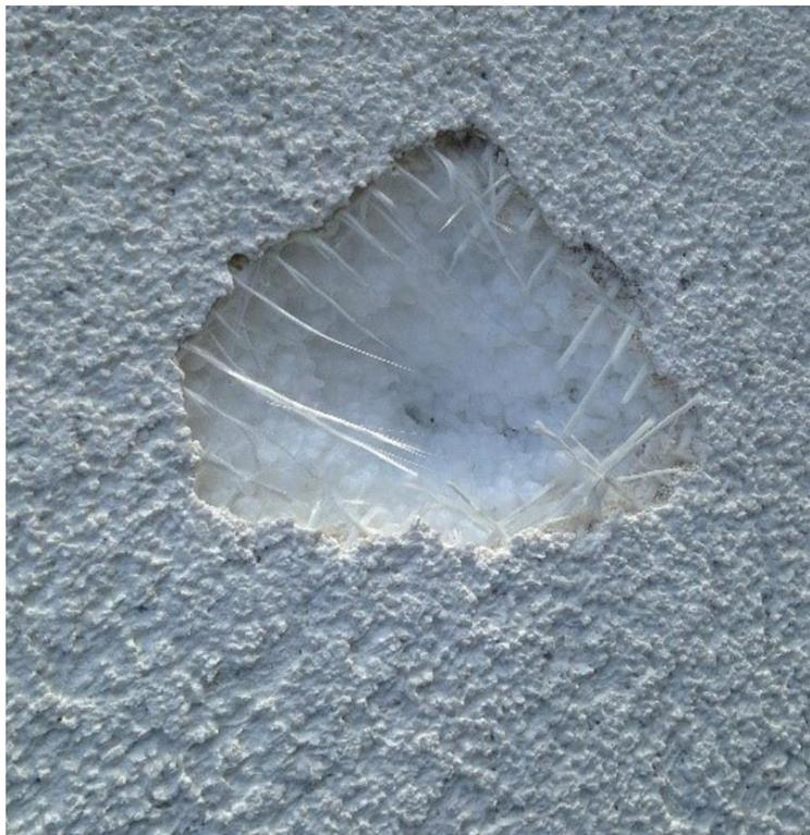
L'apparition de fissures ou des dégâts par des éléments extérieurs dans un système ETICS est bien souvent alarmante pour les propriétaires d'une habitation.
