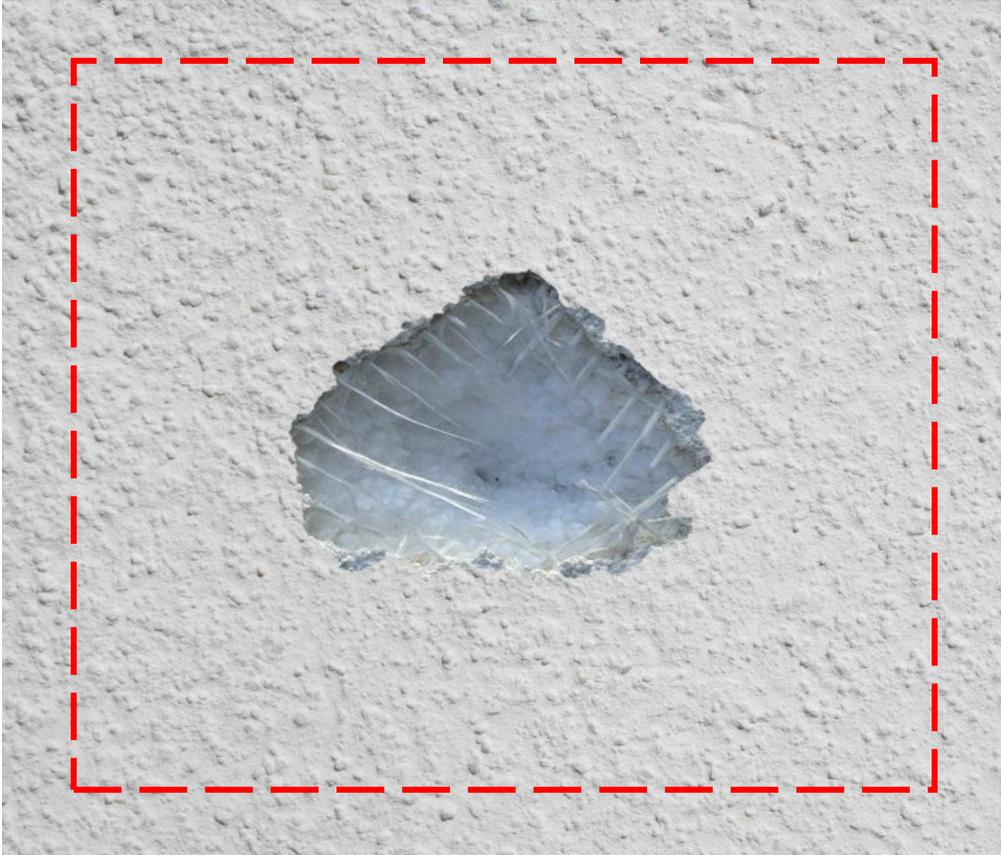
Enlever le crépi à l'aide d'une disqueuse au disque diamanté. Atténuer les bords en biais par ponçage sur 10 cm de large jusqu'à la limite de l'enduit de mortier.
