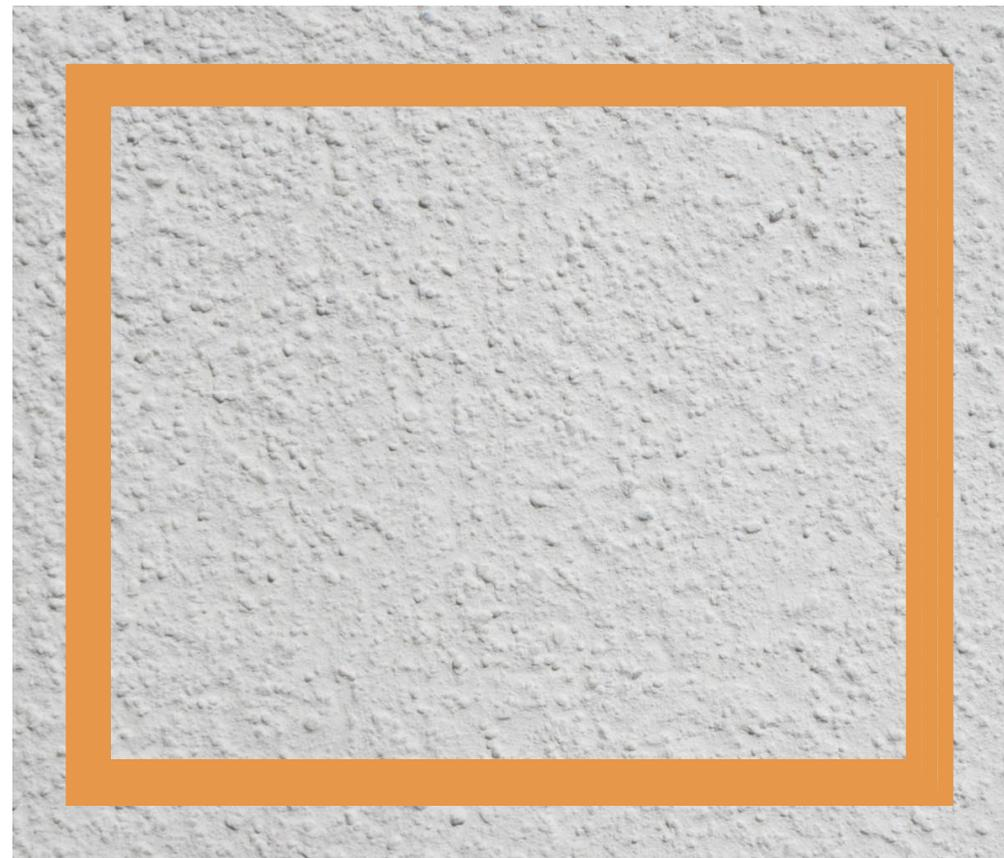
Afin d'éviter une surépaisseur du nouvel enduit sur l'enduit existant, coller des bandes adhésives au bord du crêpe existant. Appliquer le crêpe, enlever ensuite les bandes de protection, éponger légèrement en atténuant l'enduit entre l'ancien et le nouveau avec une petite éponge ronde, laisser sécher le travail est terminé. Procéder de la même manière pour les fissures.
