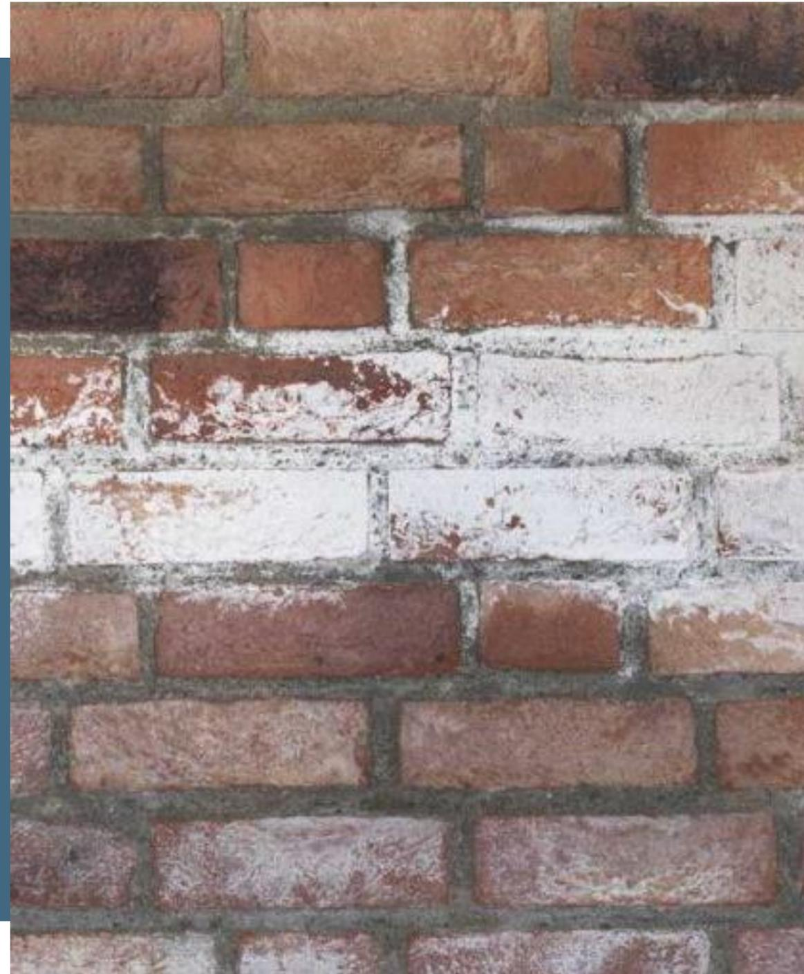
Les composants solubles dans l'eau sont évacués vers la surface par les pores de la brique et les joints de mortier. Les sels alors commencent à se cristalliser en séchant formant un voile visible blanc.
