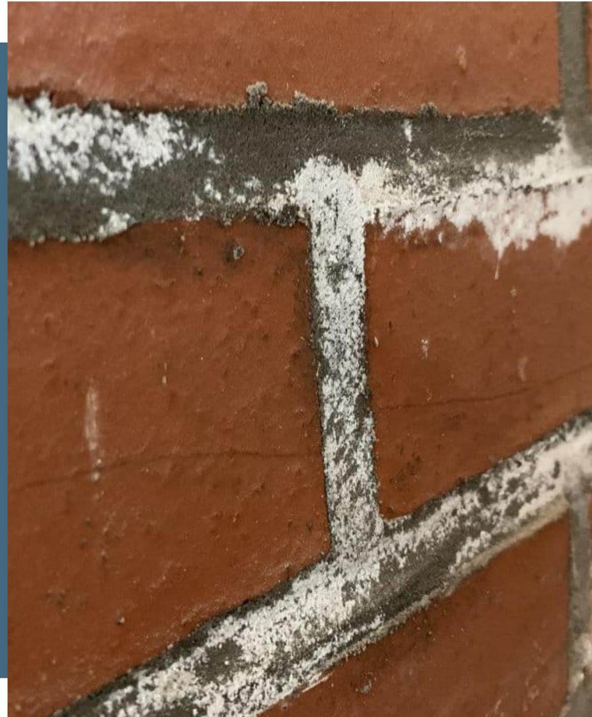
Le lessivage est le phénomène de l'eau entrant dans la maçonnerie et principalement sur la maçonnerie fraîche. Par la pluie ou en utilisant trop d'eau, les joints de mortier sont gorgés d'eau. De ce fait, la carbonatation (réaction chimique) de la chaux « libérée » dans le joint de mortier est ralentie.
