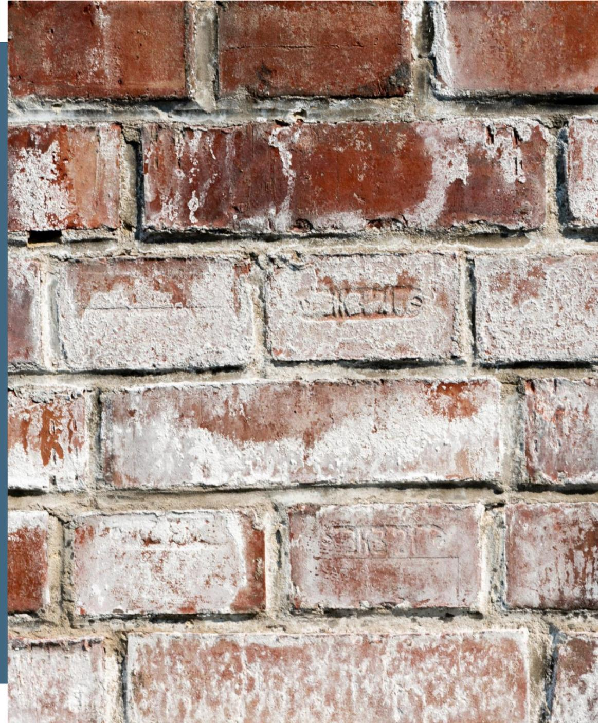
Il se présente comme un voile blanc assez tenace qui se dépose sur le parement de façade après un certain temps et qui s'étend systématiquement sur l'ensemble de la façade.
