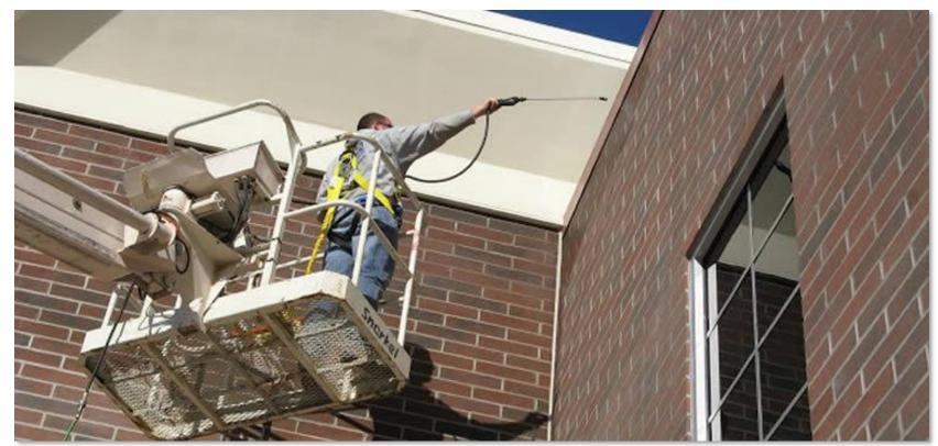
Différents produits imperméabilisants existent, que ce soit pour une grande surface ou une petite surface extérieure, ces produits s'emploient aussi bien pour une façade que pour une toiture.
