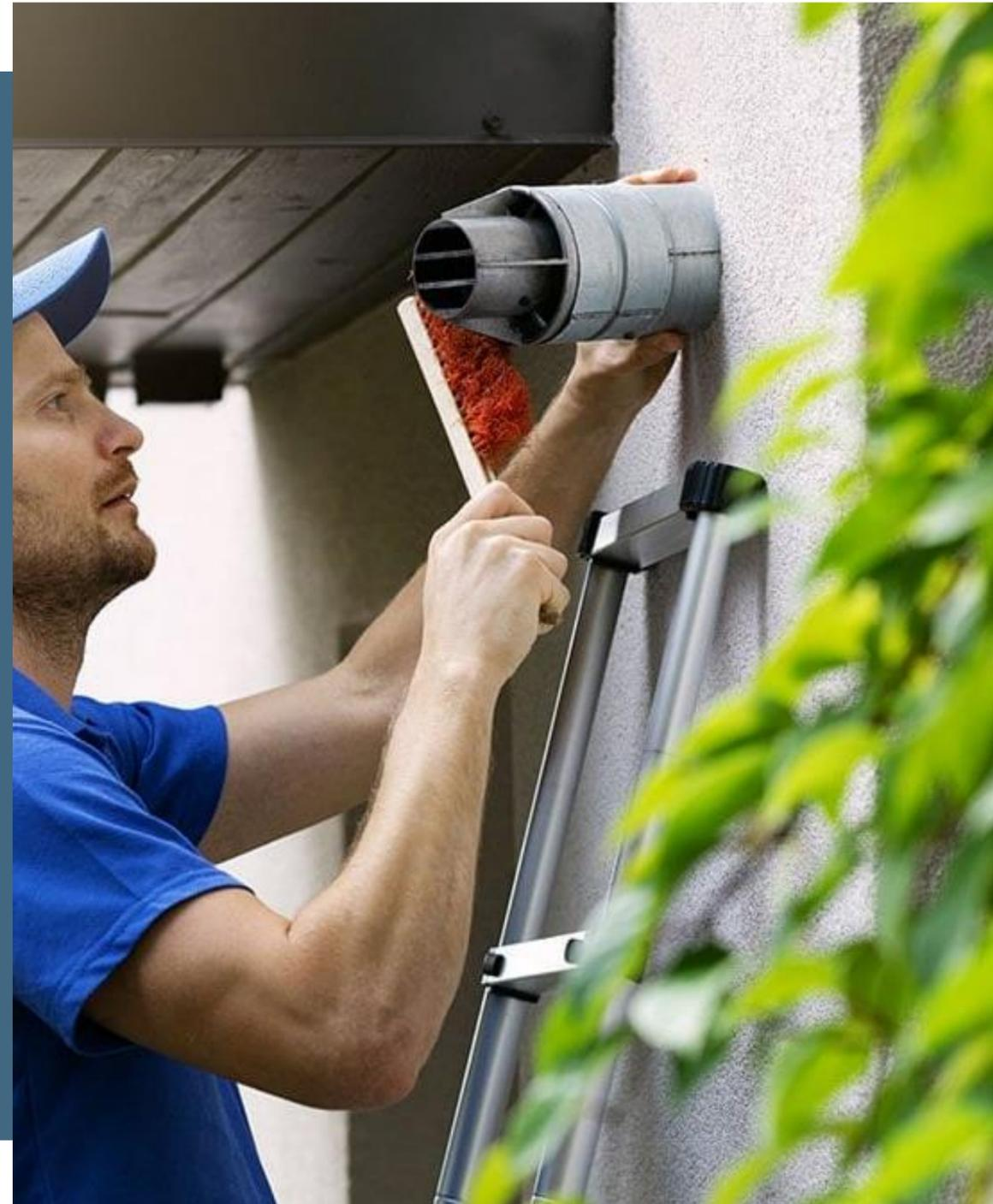
Au fil du temps, certains accessoires fixés aux façades et joints mastic des menuiseries peuvent être usés et occasionner des infiltrations et potentiellement être dommageables pour un bâtiment ayant un système d'isolation par l'extérieur.
