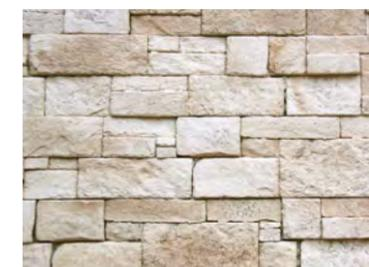
3. En pose extérieure ou pièce humide, nous recommandons d'hydrofuger.
