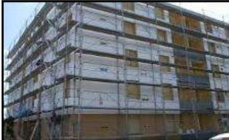
La pose du système isolant s'effectue à l'échafaudage stabilisé (fixe ou mobile de pied)
