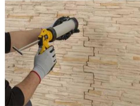
Nous recouvrons les vis avec du mastic et, en cas d'imperfections, nous retoucherons les joints entre les panneaux.
