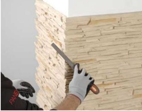
Avant de fixer la deuxième partie au mur, nous visons en unissant de façon transversale les 2 extrémités des panneaux (avec des vis plus fines, 2 ou 3 selon hauteur du panneau). Nous retirons l'excès de mastic avec une spatule. Nous finissons de fixer totalement la deuxième partie de l'angle et, si besoin, avec une lime nous retouchons l'angle pour égaliser les hauteurs entre les panneaux
