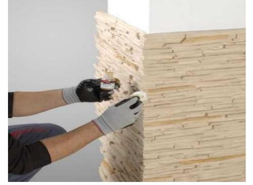
À la suite, là où cela soit nécessaire, nous retouchons les panneaux avec le pigment spécifique à chaque modèle. Nous l'appliquons en poudre à l'aide d'un pinceau fin ou d'un chiffon, toujours à sec, jusqu'à l'obtention d'une finition impeccable.
