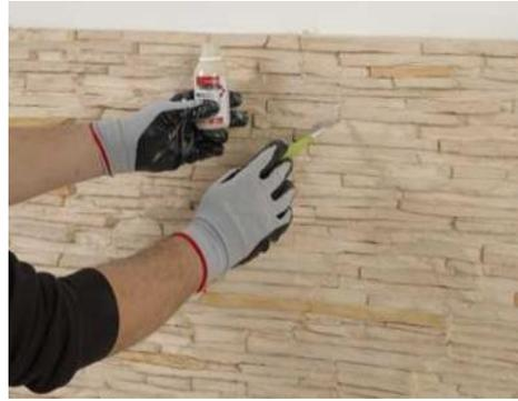
Nous laissons sécher le mastic pendant 24 heures. Avec la peinture pour retouches Panespol, nous retouchons les vis et les joints entre les panneaux
