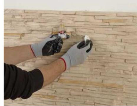
À la suite, nous retouchons les panneaux avec le pigment spécifique à chaque modèle. Nous l'appliquons en poudre à l'aide d'un pinceau fin ou d'un chiffon, toujours à sec, jusqu'à l'obtention d'une finition impeccable.
