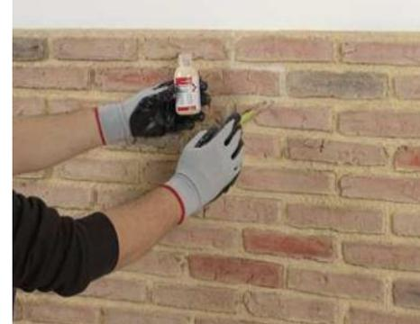
Une fois tous les panneaux mis en place, nous laissons sécher le mastic pendant 24 heures. Avec la peinture pour joints Panespol, nous retouchons les joints et les vis.
