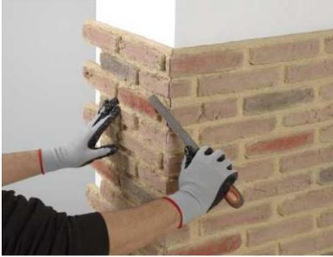
Avant de fixer la deuxième partie au mur, nous vissons en unissant de façon transversale les 2 extrémités des panneaux (avec des vis plus fines, 2 ou 3 selon hauteur du panneau). Nous retirons l'excès de mastic avec une spatule. Nous finissons de fixer totalement la deuxième partie de l'angle et, si besoin, avec une lime nous retouchons l'angle pour égaliser les hauteurs entre les panneaux
