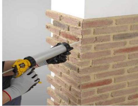
Une fois tous les panneaux mis en place, nous recouvrons les vis avec le mastic et, en cas d'imperfections, nous retouchons également les joints.
