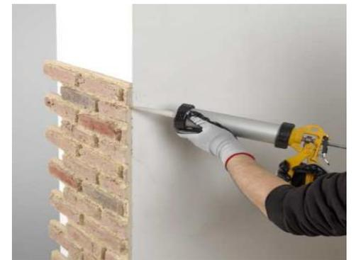
Une fois le panneau posé, nous appliquons du mastic sur la partie de l'onglet. Nous posons le panneau suivant qui par sa forme s'encastre parfaitement. Le panneau doit faire pression sur le mastic.
