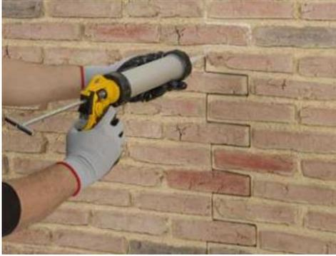
Nous recouvrons les vis avec du mastic et, en cas d'imperfections, nous retoucherons les joints entre les panneaux.
