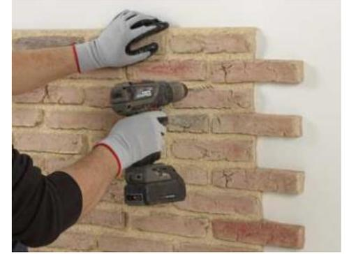
Nous perçons en même temps le panneau et le mur. Nous ferons les trous sur la zone des joints, de cette façon les retouches avec le mastic seront plus faciles.
