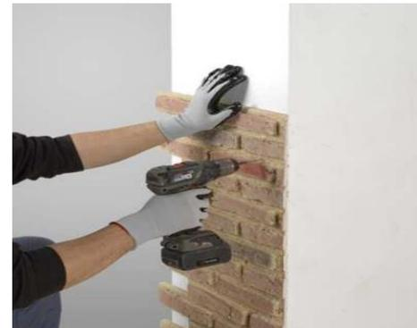
Nous plaçons le panneau sur le mur et nous perçons en même temps le panneau et le mur. Nous ferons les trous sur la zone des joints, de cette façon les retouches seront plus faciles. Nous assemblons au préalable la vis et la cheville ; nous les introduisons dans le trou à l'aide d'un marteau de façon à ce que la cheville soit rentrée dans le panneau à 2-3mm du bord puis nous visons en appuyant jusqu'à ce qu'elles soient fraisées.
