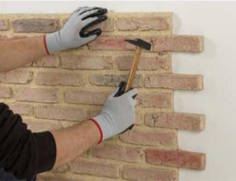
Nous assemblons au préalable la vis et la cheville ; nous les introduisons dans le trou à l'aide d'un marteau de façon à ce que la cheville soit rentrée dans le panneau à 2-3mm du bord puis nous vissons en appuyant jusqu'à ce qu'elles soient fraisées. Il est recommandé de visser tout le périmètre ainsi qu'une partie centrale (Utilisez au moins une douzaine de vis par m2 ; le double pour l'extérieur).
