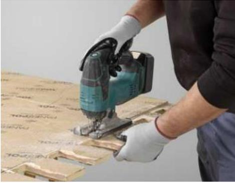
Nous présentons le panneau sur la surface où il doit se situer et nous traçons une ligne. À l'aide d'une scie sauteuse nous coupons le panneau sur la ligne marquée au préalable.
