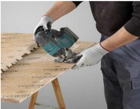
Nous présentons le panneau sur l'angle et nous traçons sur le dos de celui-ci la ligne qui requiert l'onglet. À l'aide d'une scie sauteuse à 45° nous coupons le panneau en suivant la ligne marquée au préalable.
