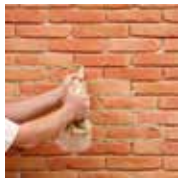
2 - Je réalise les joints
