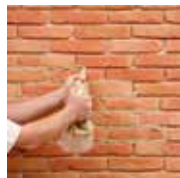
2 - Je réalise les joints
