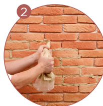
Je réalise les joints
